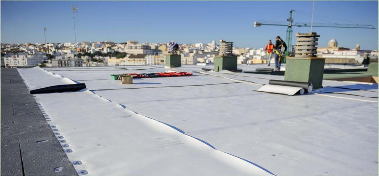
Esta membrana está diseñada para ser aplicada tanto en cubiertas donde la impermeabilización queda expuesta a la intemperie como en cubiertas invertidas en las que se coloca sobre ella algún tipo de lastre o cubrición. Es una membrana resistente a los agentes exógenos (UV, granizo, lluvia ácida, etc.) y endógenos (cargas mecánicas, vapor de agua, etc.) y contiene retardadores de llama. En nuestro caso se decide que debe quedar permanentemente expuesta a la intemperie sin lastre o cubrición.
